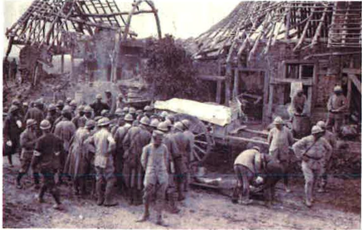
Figure 1. Poste de secours installé dans les ruines d'Herbécourt.
